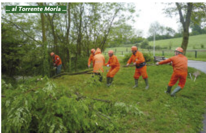
Lavori alle Mura Venete...
